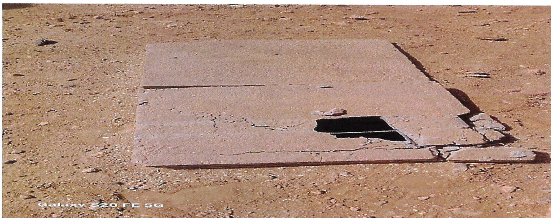
Figure n° 04 : Dalle en béton couvrant un caniveau de passage de câbles du balisage endommagée suite au passage de la roulette de nez de l'avion après sortie de piste
