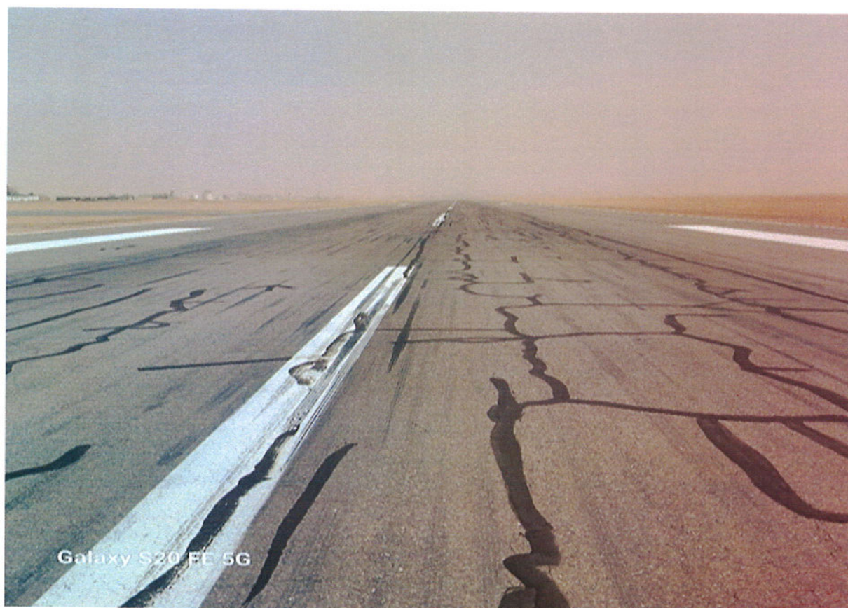
Photo n° 09 Traces de pneus éclatées du train principal côté droit à 1400 mètres du QFU 03
