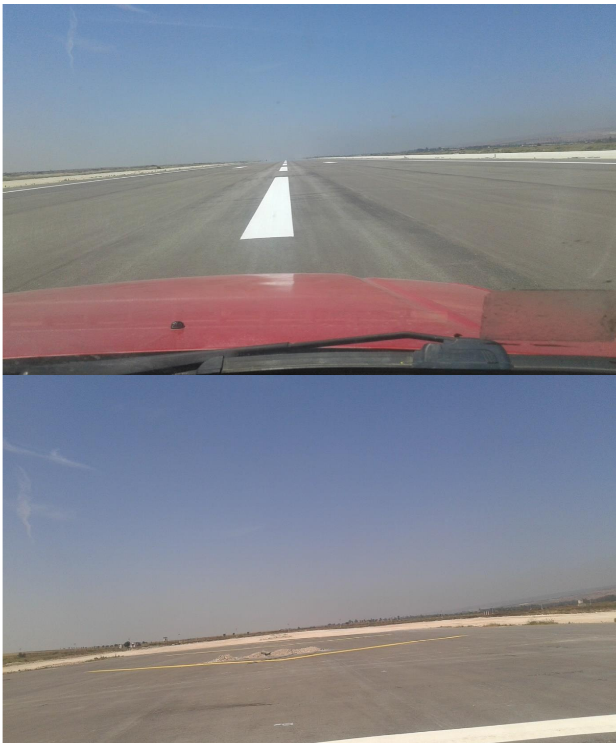
Figure 4 : Gravas déposés au seuil de piste fermée 7L
